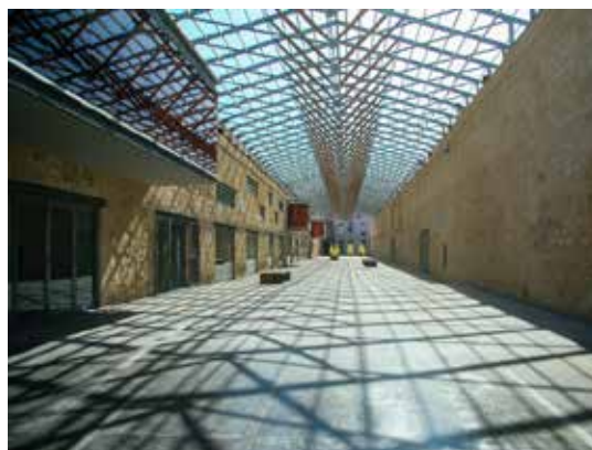
Une rue des Chartrons, désormais réhabilitée et recouverte d'une toiture. Les façades des chais comme celle de droite sont presque aveugles (face à la rue du Faubourg des Arts).
